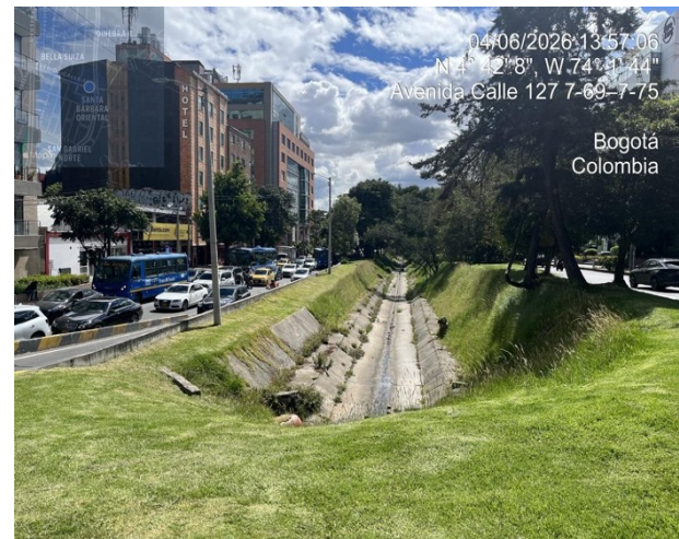
Fotografía No. 4: Estructura ecológica principal canal Callejas en Calle 127 con Carrera 7.
