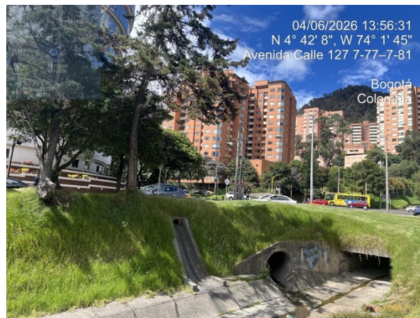
Fotografía No. 7: Box culvert canal Callejas Calle 127 con Carrera 7, sentido occidente.
