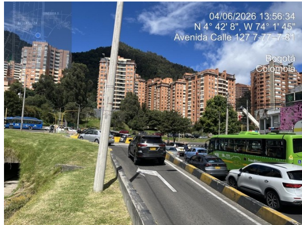
Fotografía No. 5: cruce vehicular sobre canal Callejas Calle 127 con Carrera 7.
