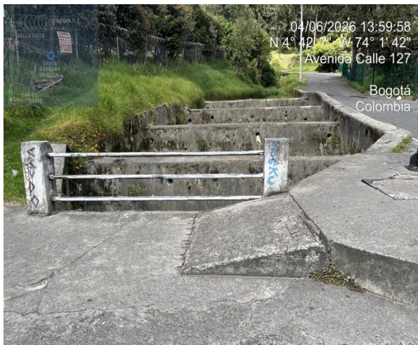
Fotografía No. 3: Box culvert en canal Callejas cruce Calle 127 con Carrera 7.
